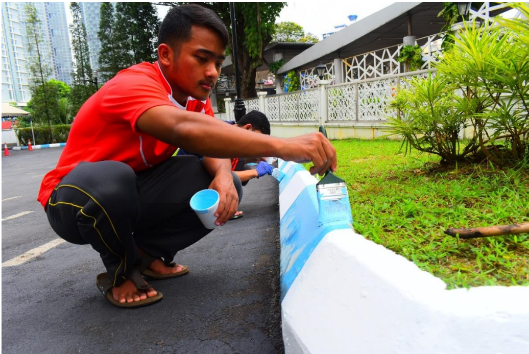
Gambar 3 & 4: Aktiviti mengecat pembahagi jalan
